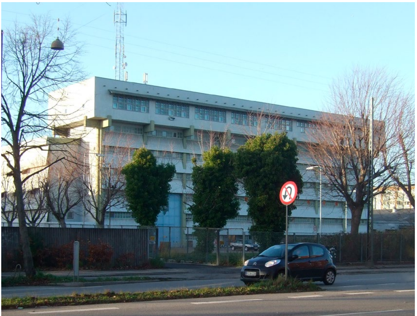
Hovedbygningen til Bellahøj Koblingsstation
