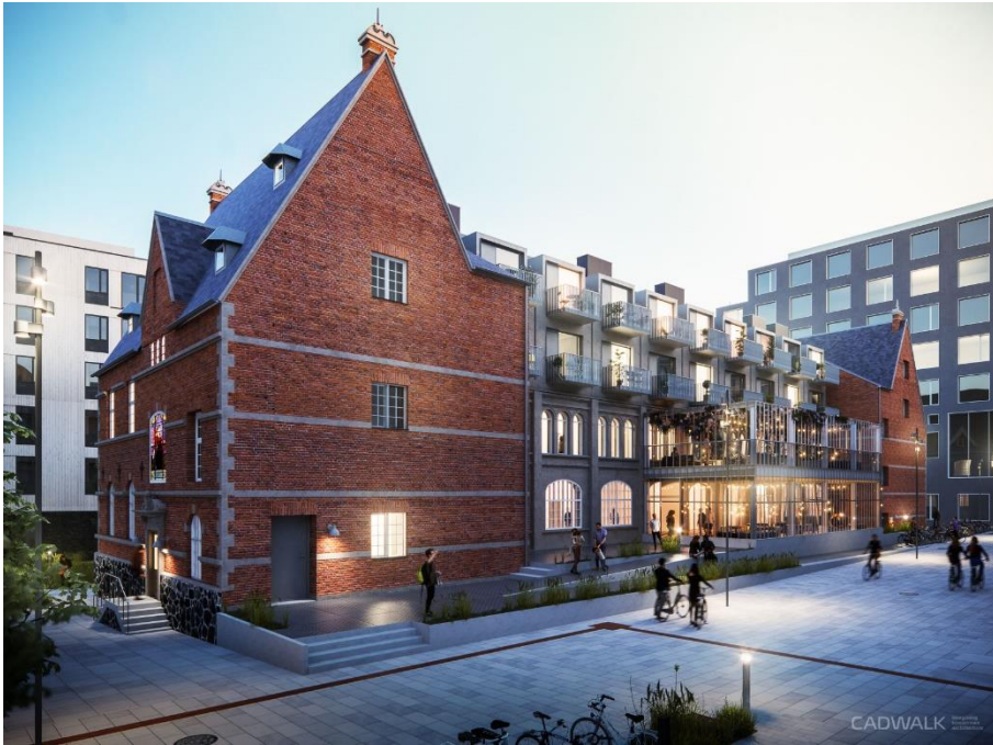
Bygningen set fra Kildepladsen. Kreditering: CADWALK og Carlsberg Byen.
