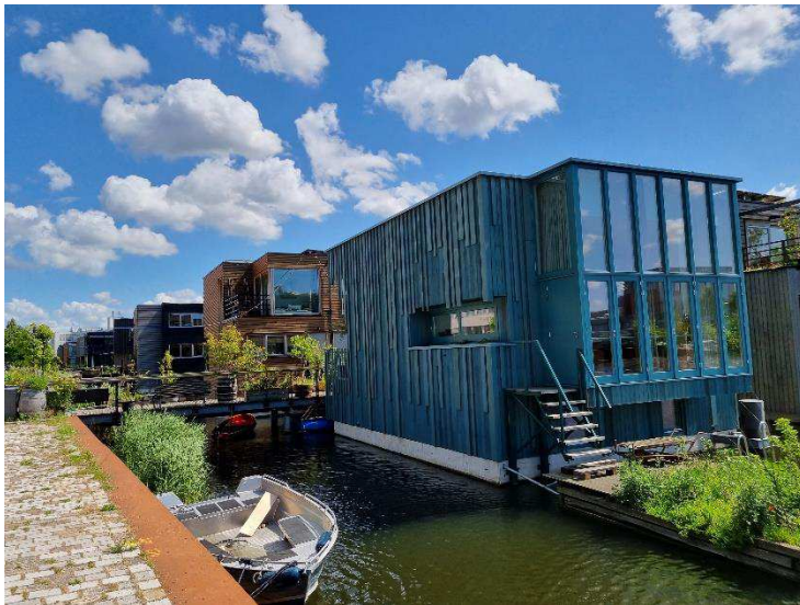
Flydende boliger som byggefællesskab i kvarteret Buiksloterham
