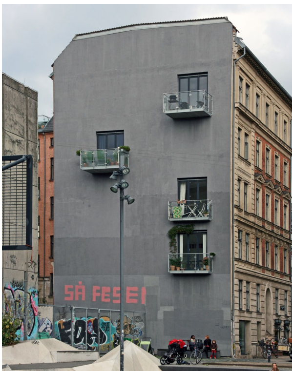
Ahlefeldtsgade. Den forskudte placering og de enkelt udformede altaner med transparente værn skaber liv på facaden samtidig med at de enkelte altaner får mere lys.
