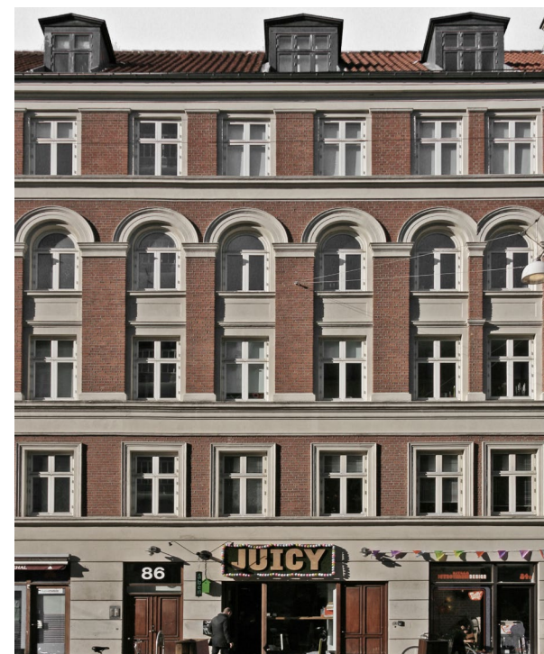
Istedgade. Kombinationen af de meget markante rundbuer og gesimsen over dem gør det udfordrende at opnå en god helhedsvirkning med altaner på 4. sal.
