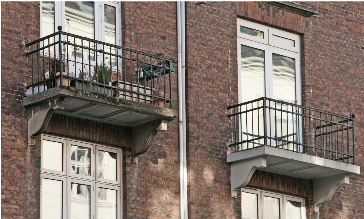
Sommerstedgade. Restaureret oprindelig altan.
