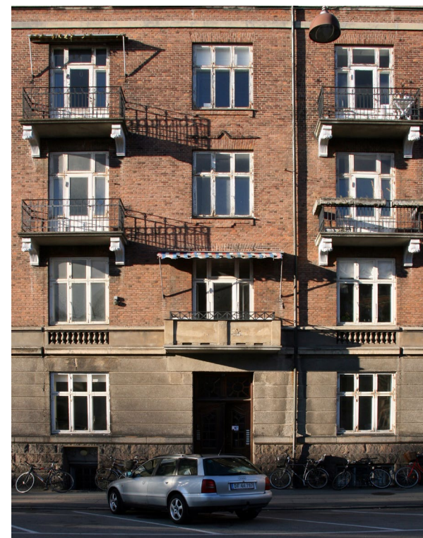
Kastelvej. Oprindelige altaner i forskellige udformninger, der forholder sig til deres placering på facaden.
