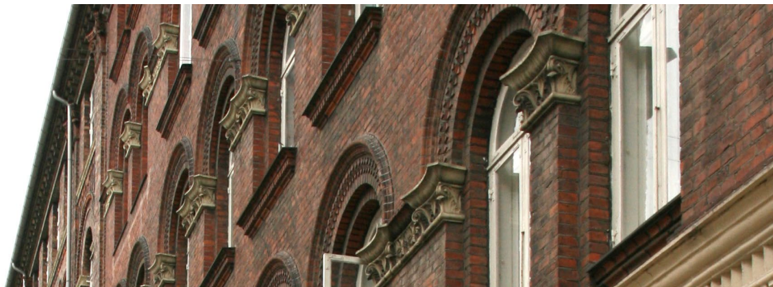
Holbergsgade. Detaljerig muret facade med rundbuer
