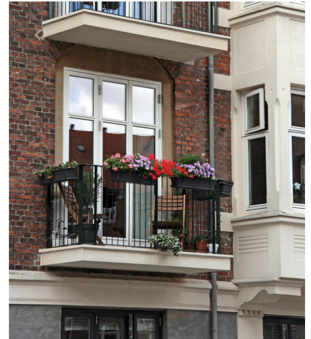
Bevtoftegade. Altanen er tilpasset til dybden af karnappen og holder en respektafstand til karnappen, der svarer til dybden. Bunden har en detaljering og stoflighed, der harmonerer med karnappen.
