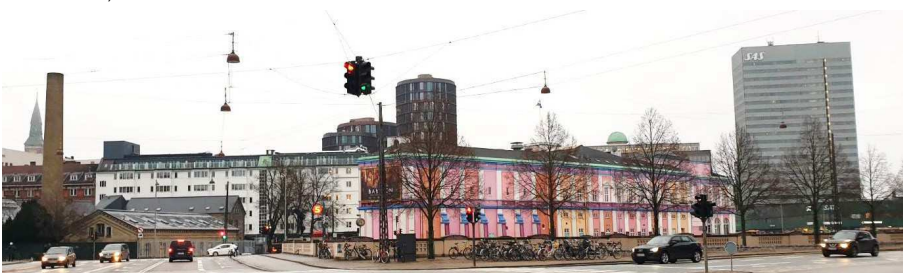
Palads og omkringliggende bebyggelse udgør byens base, hvorfra enkelte højhuse og tårne skyder op. Set fra nordvest.
