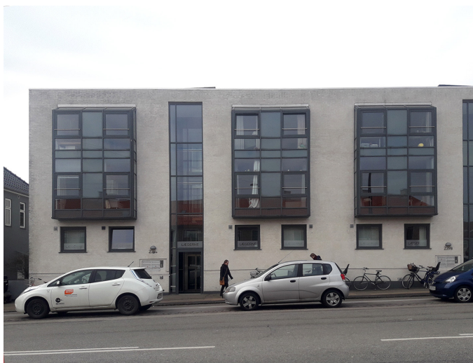
Facaden på Godthåbsvej 239
