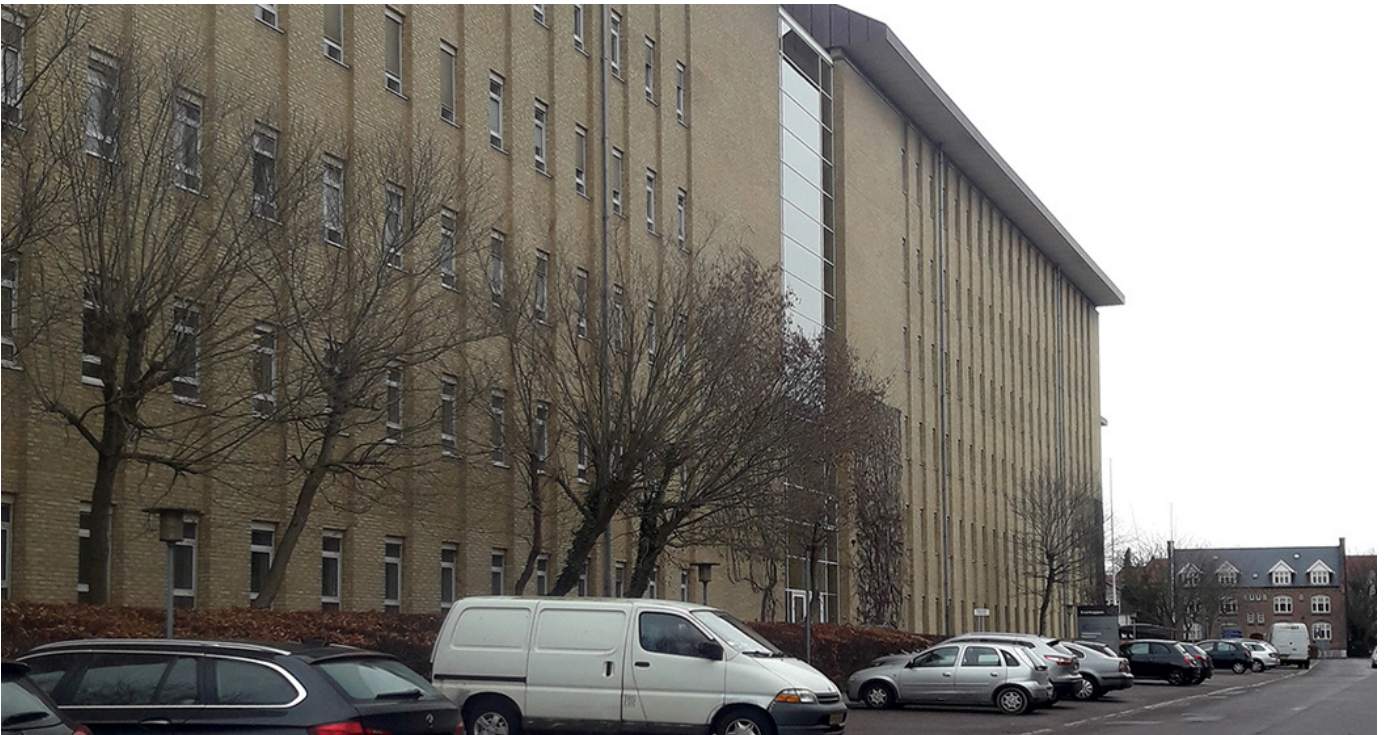
Billede af facaden på Kruntappen 2-4 set fra Ottliavej mod Tre Kronergade.
