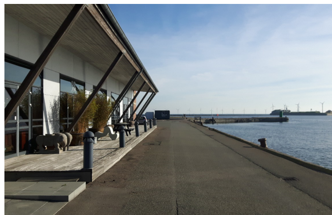
Der skal etableres promenadeforløb langs Sundkaj (vist på billedet) og Orientkaj, der ender i spidsen med fyret. Langs Sundkaj skal der være mulighed for at færdes på cykel.
