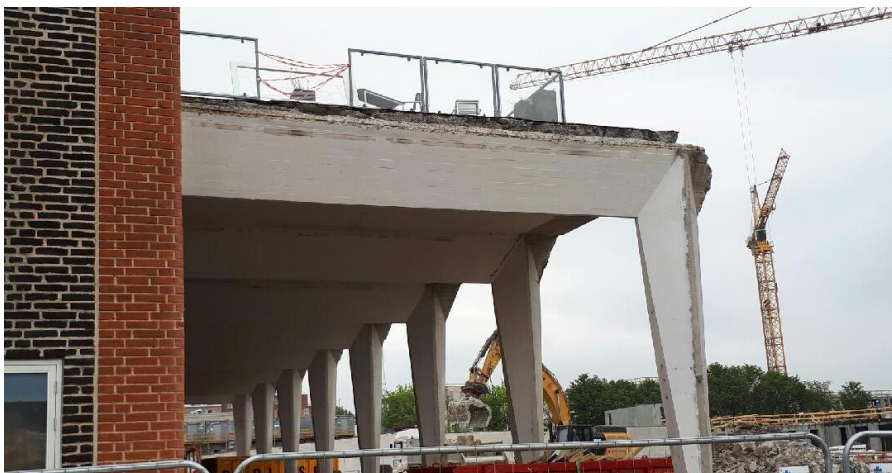
De blotlagte bygningskonstruktioner på Lindgreens Allé 12.
