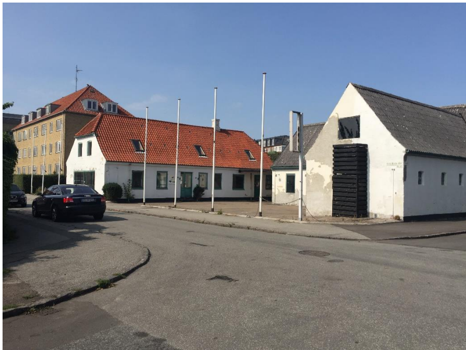
Ulrik Birchs Allé 54 set mod Nordvest fra Vatnavej.
