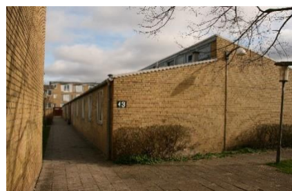
Institutionsbygninger i 1 etage og med forskudte tage
