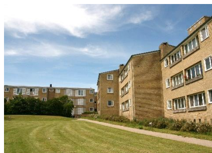
Haverum med facader der fortæner
