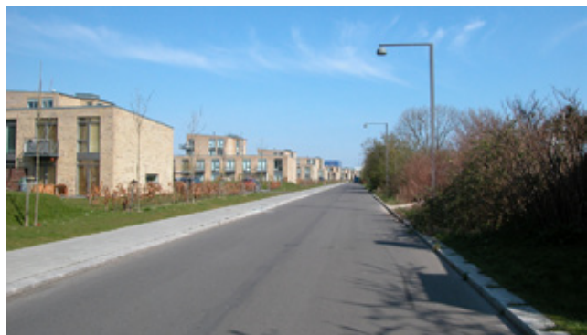
Digevej set fra syd mod DR's koncerthus som svagt skimtes i horisonten. Metroen ligger langs med bebyggelsen "Solstriben" mod vest.
