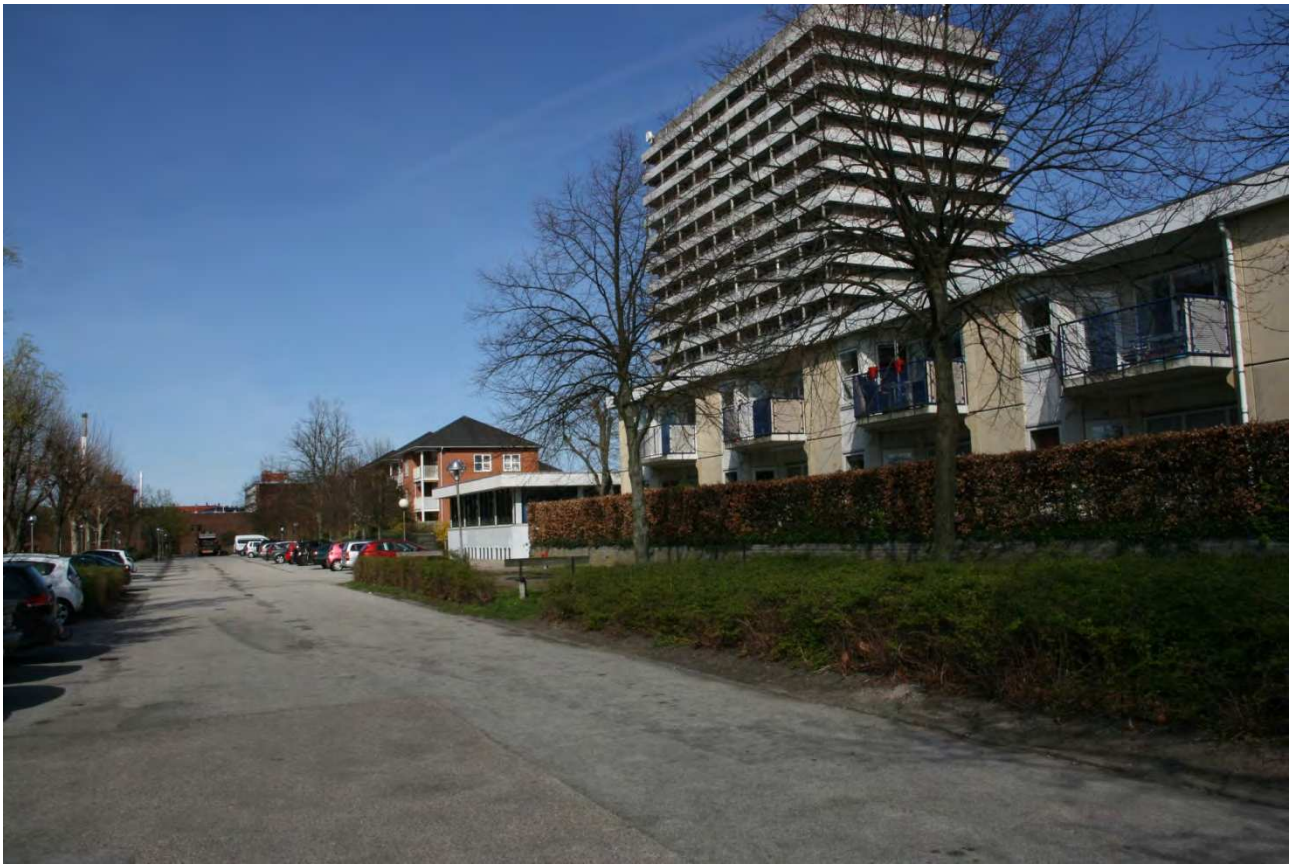
Peder Lykke Højhuset fremstår nedslidt og som et element ude af skala med det omkringliggende byområde
