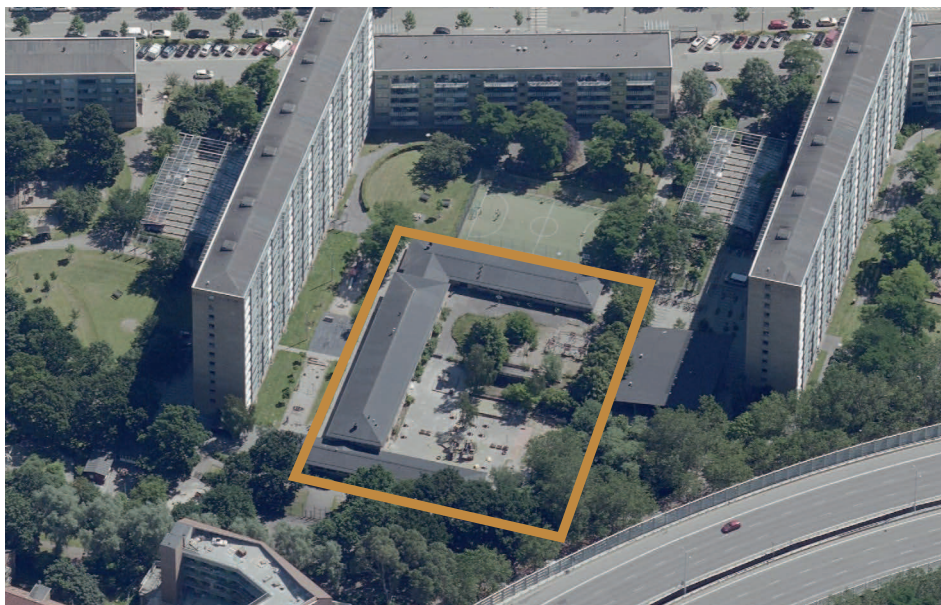
Luftfoto af daginstitutionerne, der ligger placeret mellem Lundtoftegadebebyggelsen.
