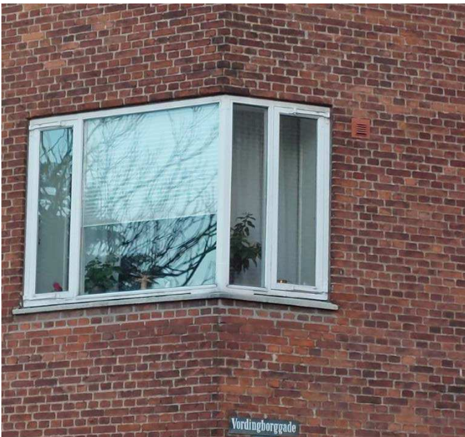
Udskiftning til energivinduer i træ
