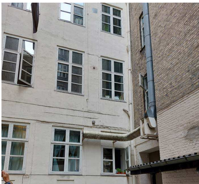
Renovering og oprydning af facader
