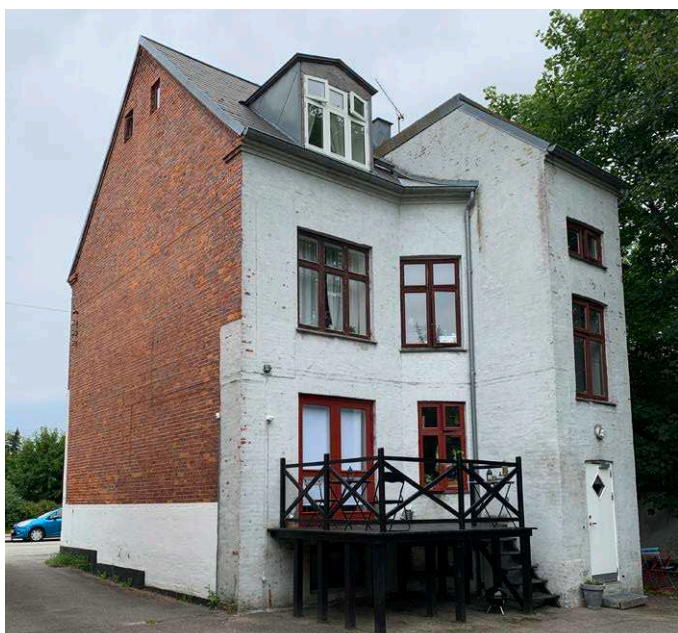
Udskiftning af vinduer og istandsættelse af facade
