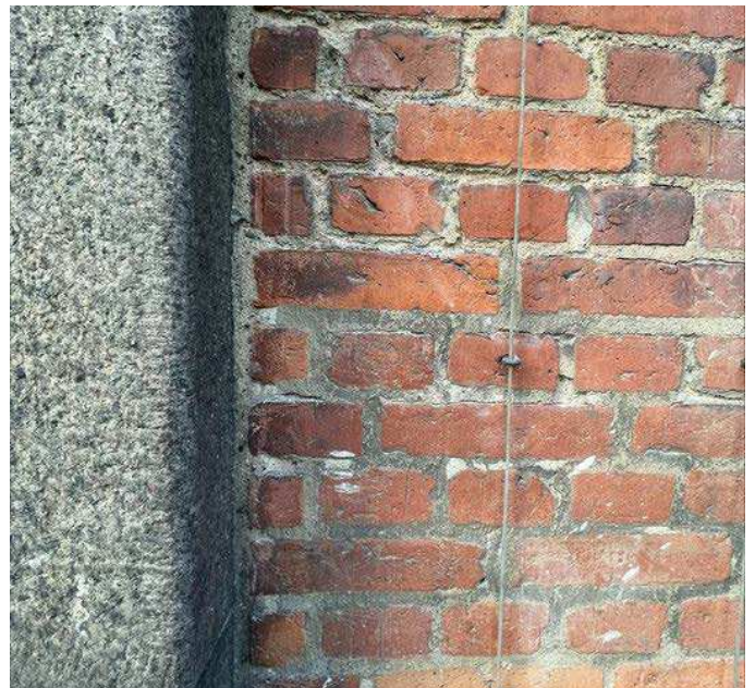
Istandsættelse af gadefacade
