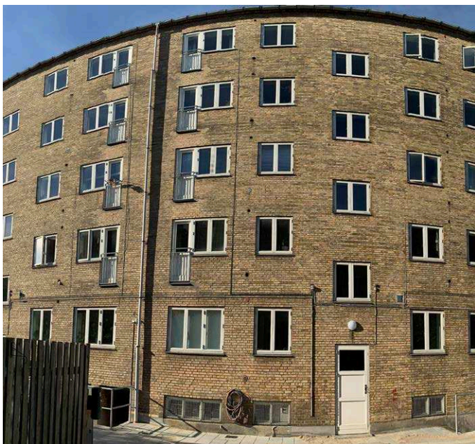
Skybrudssikring af kældernedgange
