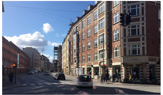
Toftegårds Allé set mod syd. Etagebebyggelsen udpeges som bevaringsværdig.
