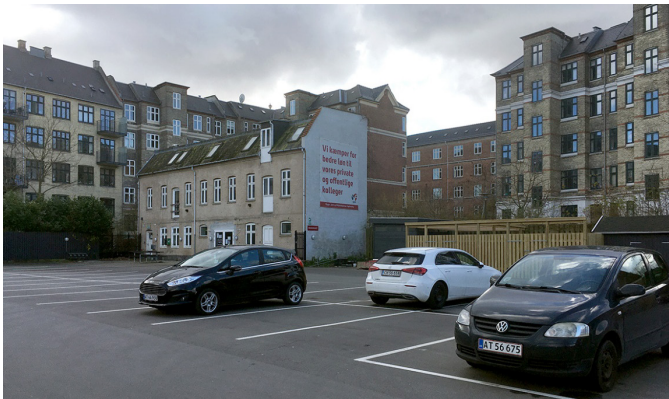
Gårdrummet set fra indkørslen på Mølle Allé, hvor daginstitution og boliger placeres. Eksisterende baghus udpeges som bevaringsværdig.
