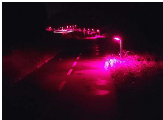
Figur 14. Rød pullertbelysning langs cykelsti.
