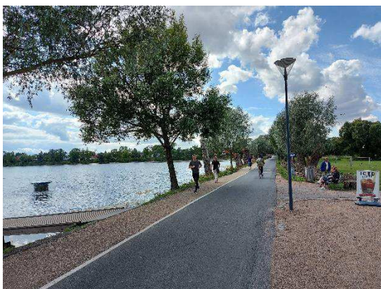
Figur 9. Eksisterende stibelysning på Damhusdæmningen (foto fra 2021).
