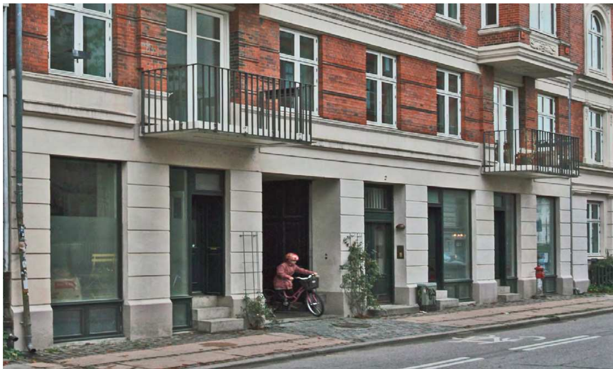
Sankt Hans Gade 2 Gesimsen er blevet brudt og de nye altaner har skåret sig ned i basen, men de tilpassede altanbunde og de enkle, spinkle værn gør, at der skabes en god helhedsvirkning.
