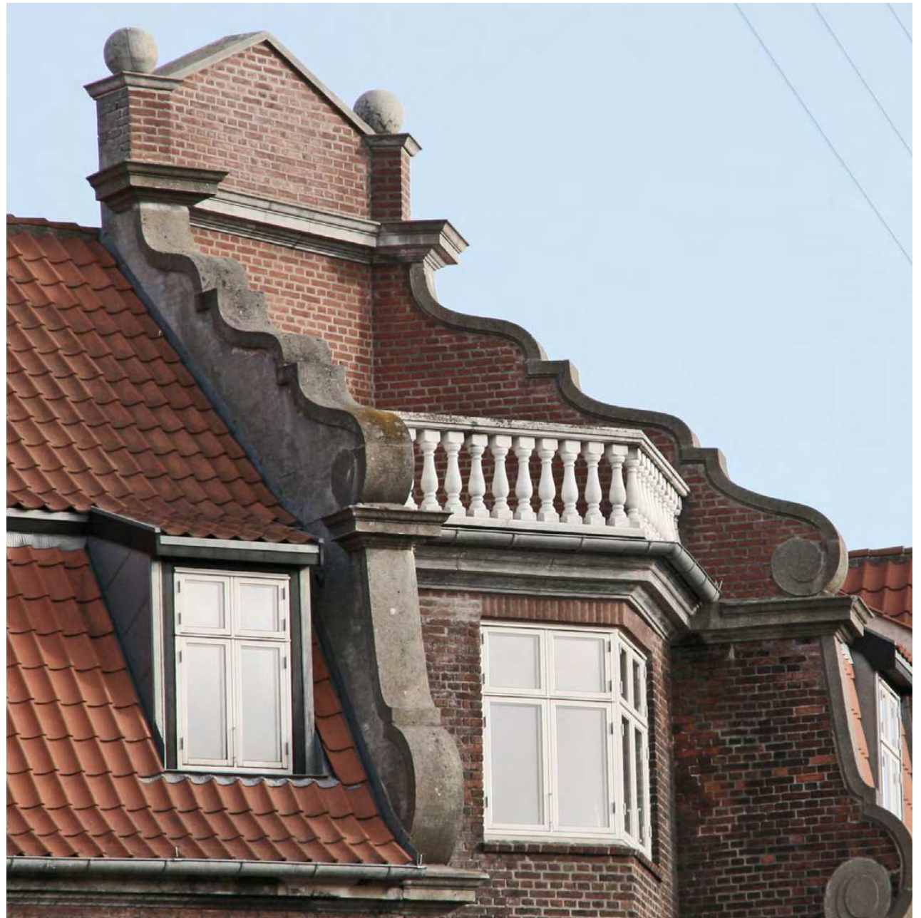
Snorregade 7 Oprindelig tagterrasse i mansardtag.
