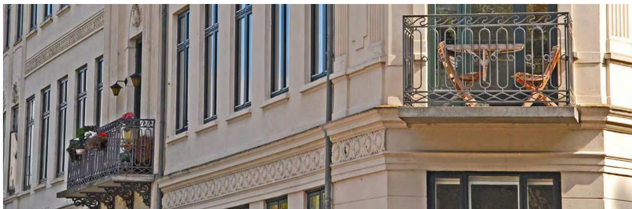
Langebrogade Ny altan på hjørnet udformet med udgangspunkt i den oprindelige.
