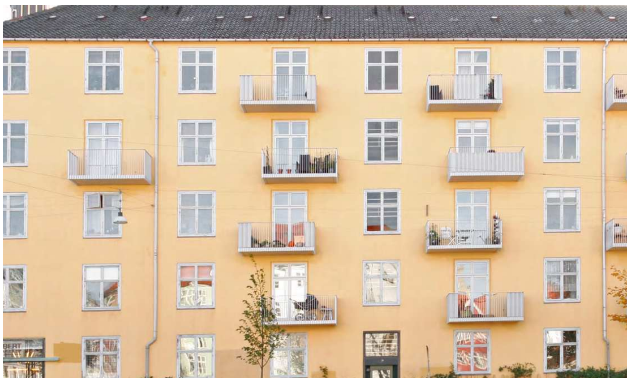
Overgaden Oven Vandet 42 Den forskudte placering af altanerne skaber en variation der harmonerer med den enkle facade.
