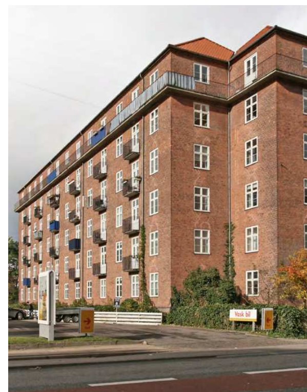
Amager Fælledvej 34 Forskellige altaner på den samme bygning.
