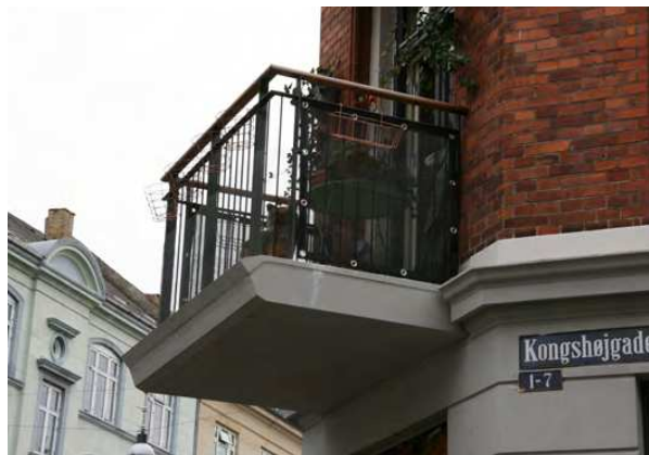
Kongshøjgade 1-7 Altanen bryder gesimsen men altanbundens materiale og udformning er tilpasset.
