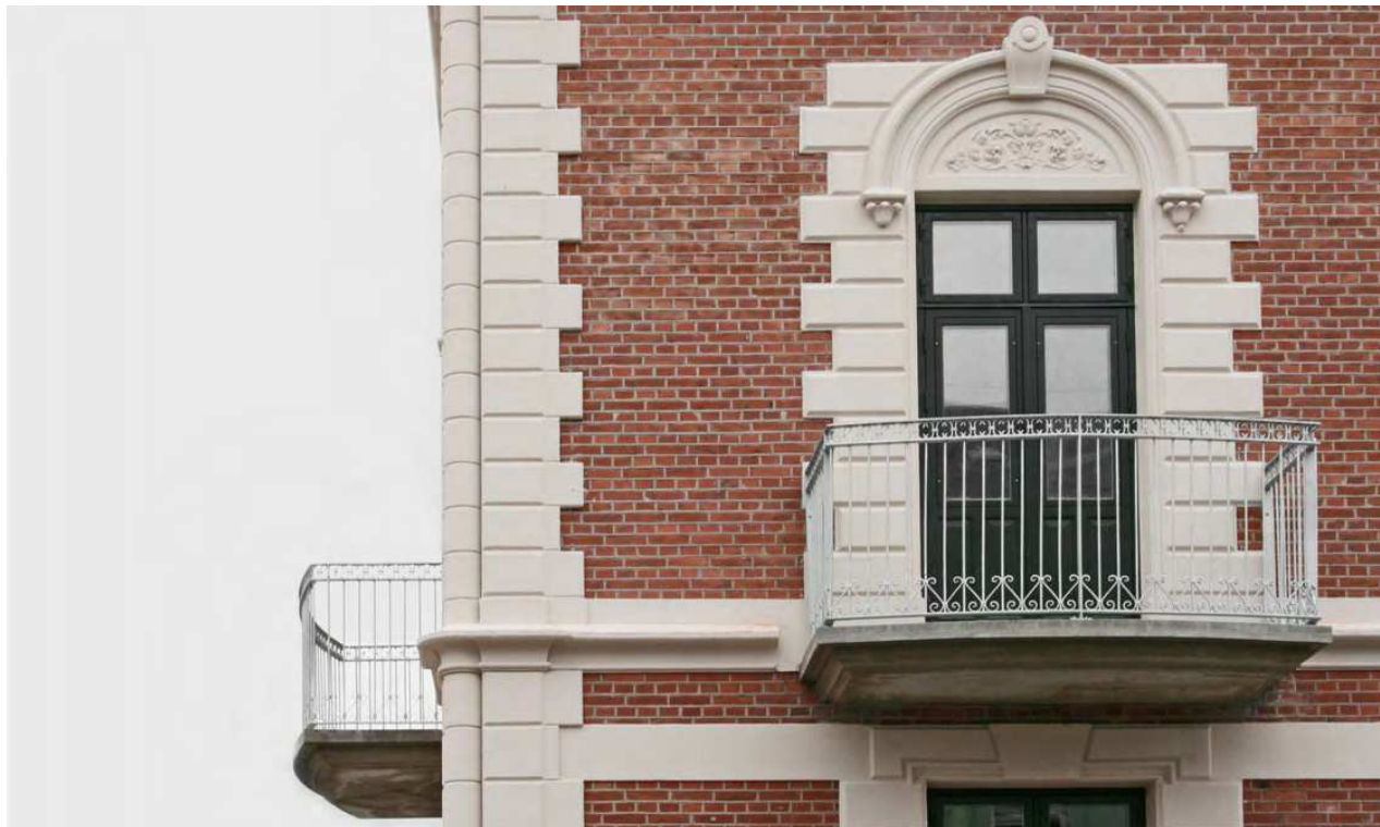
Valdemarsgade 20 Den smukke stoflighed og detaljering i betonbunden skaber sammen med de elegante spinkle værn og den let rundede front en god helhed sammen med de eksisterende dekorationer på facaden.
