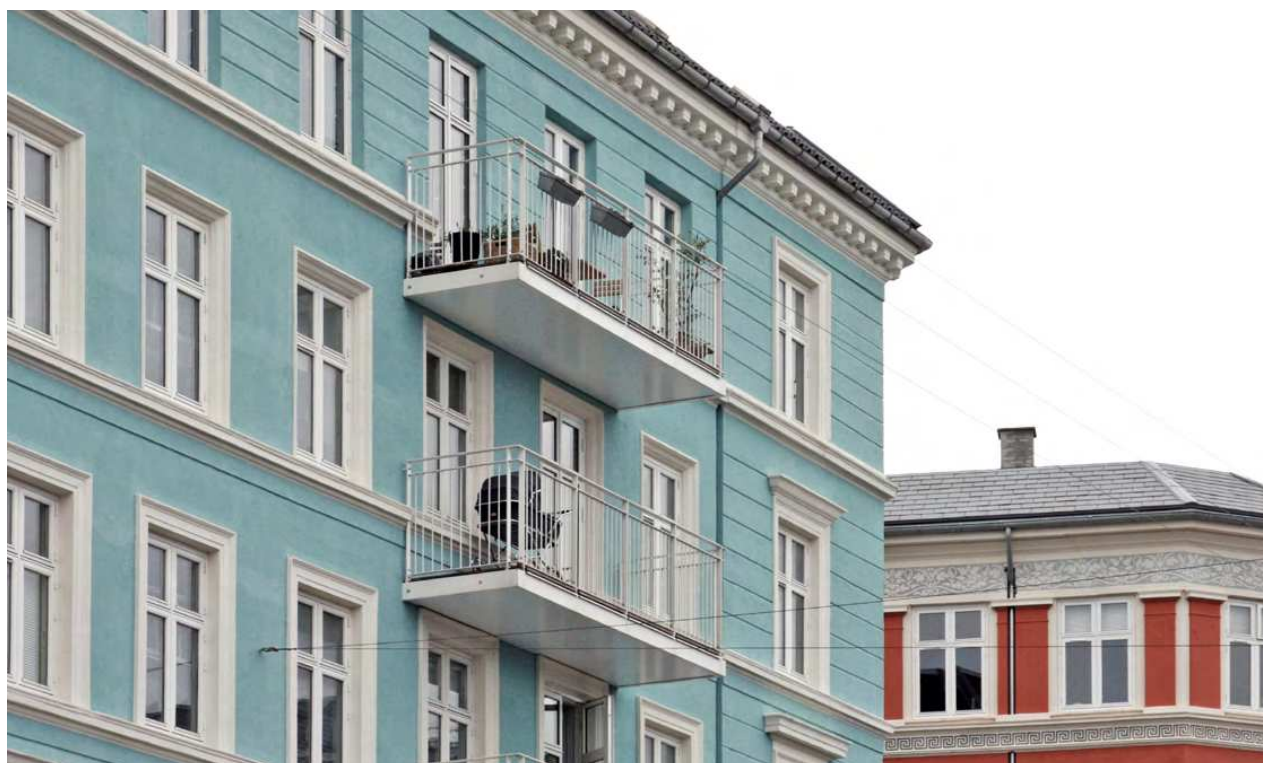
Dybbølsgade 49 Enkle hvide altaner der passer til facadens hvide dekoration. De spinkle værn og den tynde altanbund får altanerne til at virke svævende og lette.
