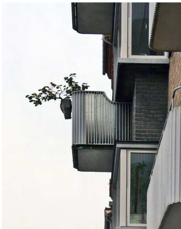
Overgaden Oven Vandet 46 Mødet mellem værn og vindue er elegant løst.
