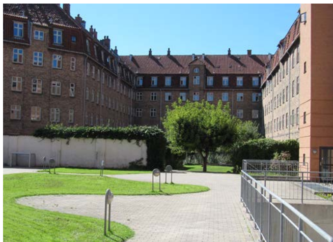
Gården til Omøgade nr. 8 med grønt anlæg og kig mod de grønne gårdanlæg til den store beboelseejendom mod Lyngbyvej.
