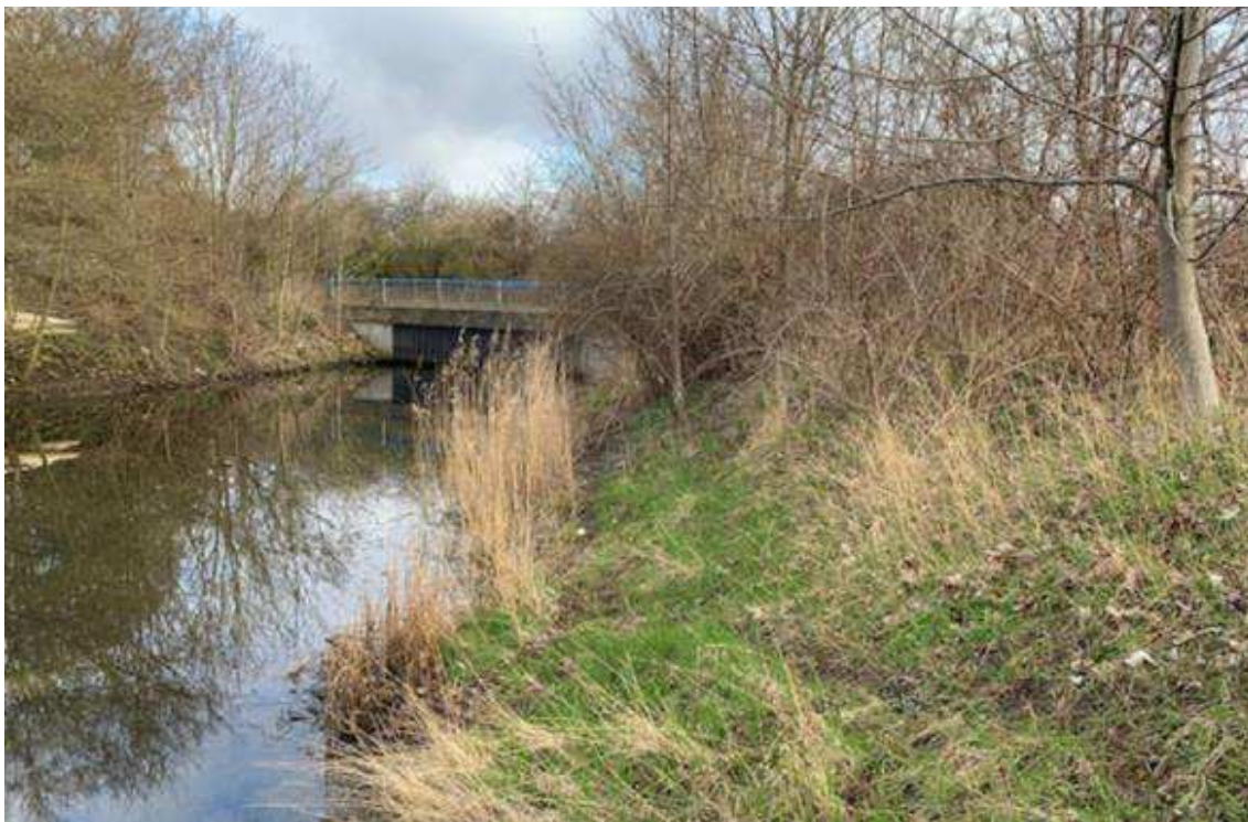
Figur 15.8: Den nordlige del af Enghave kanal, set fra syd mod nord, med overløbsbygværket i baggrunden. Foto: NIRAS, d. 13.04.2021.
