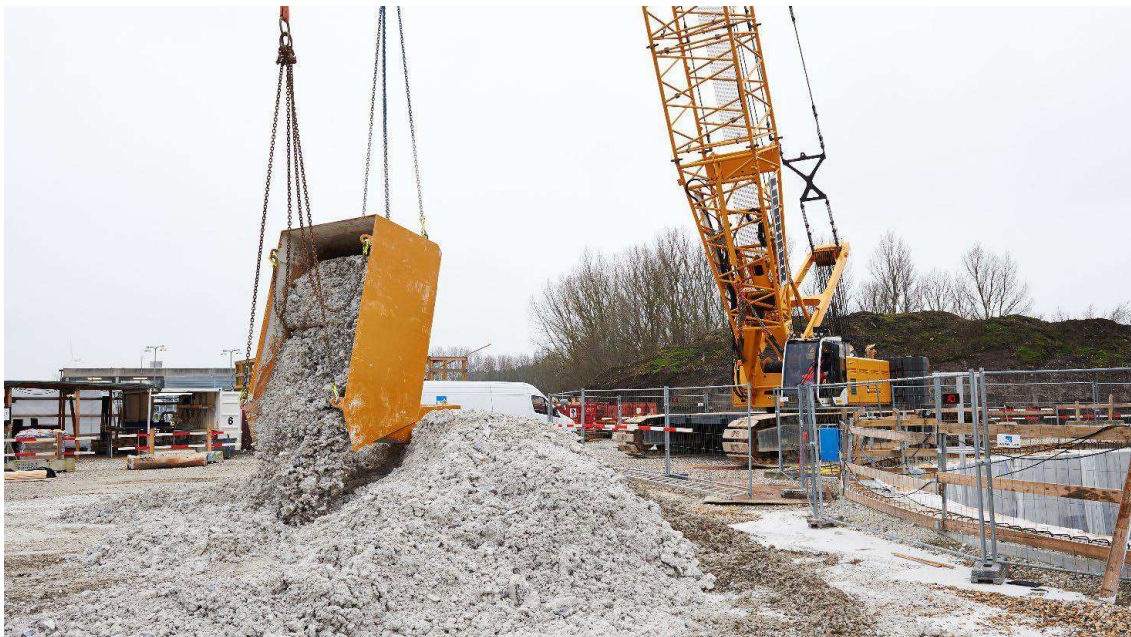
Figur 5.9 Tunnelmuck hejses op fra skakten til bortkørsel.
