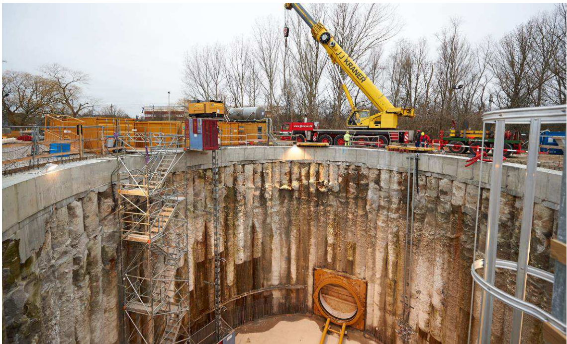
Figur 5.6 Skakt udført med sekantpælevæg.
