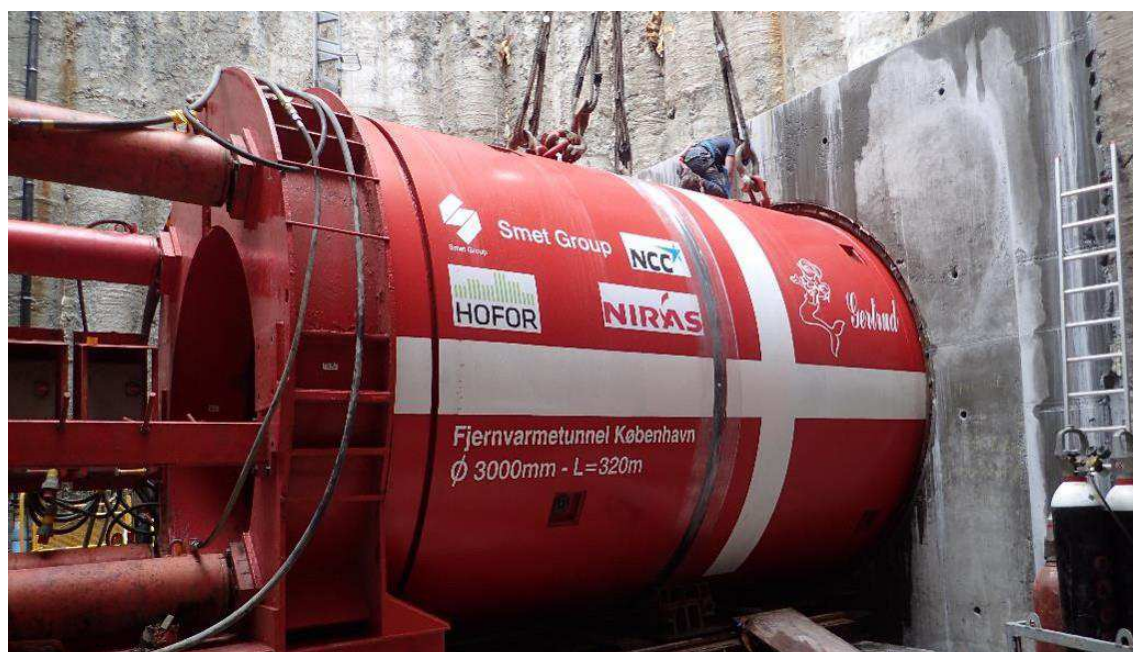
Figur 5.7 Tunnelboremaskine (TBM) klar til afsendelse gennem skaktvæggen.
