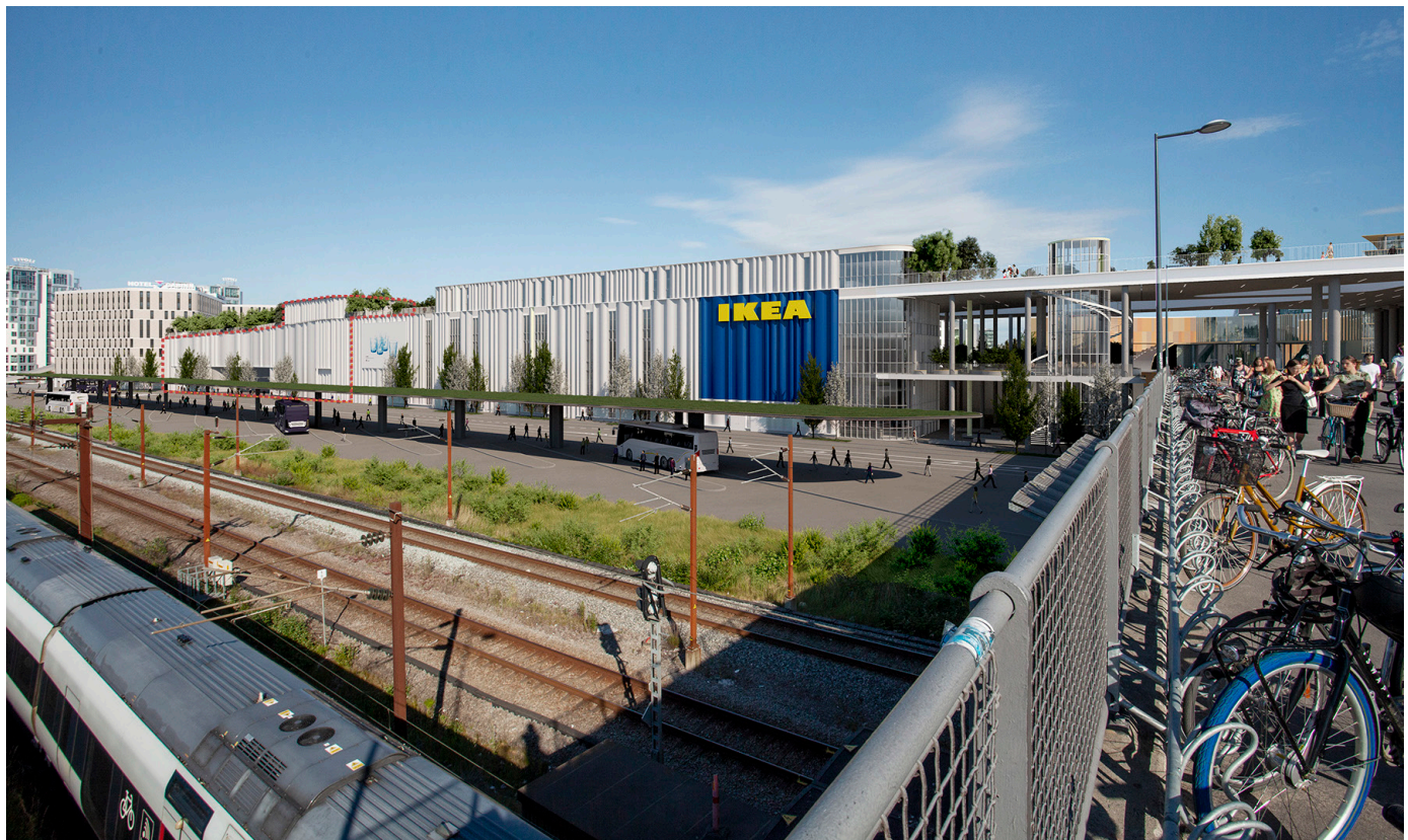
Dybbølsbro set fra vest (Vesterbro). Det muliggjorte byggeri ses midt i billedet med området for den kommende fjernbusterminal foran. Området markeret med rød stipling forudsætter supplerende lokalplan for at kunne bebygges. Illustration: Dorte Mandrup.
