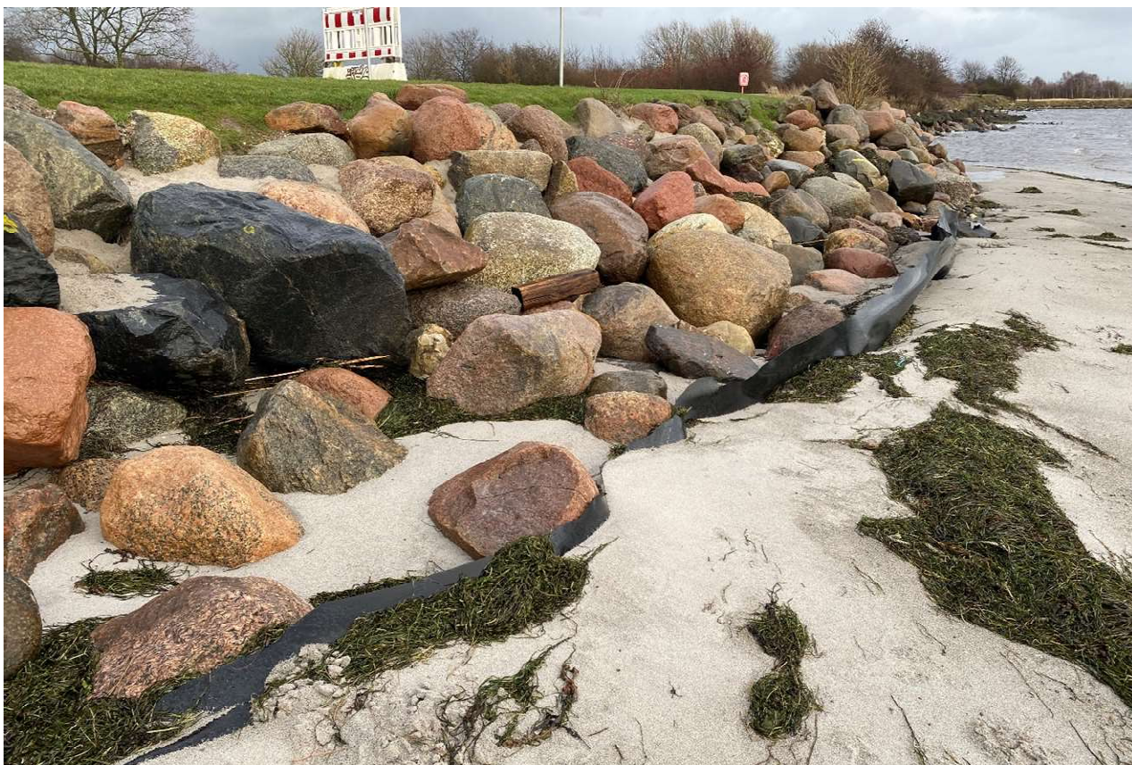
Figur 1-4: Blotlagt membran foran stenkastning mod øst.
