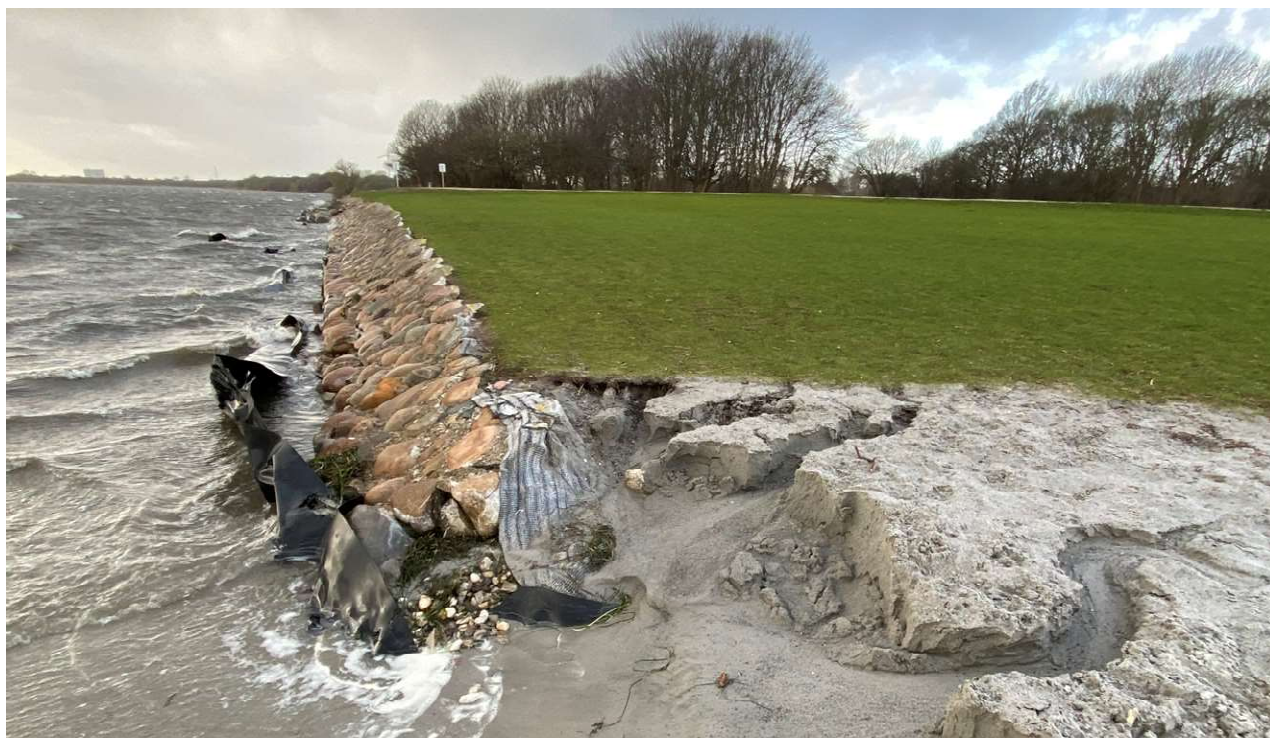
Figur 1-3: Blotlagt membran foran stenglaci mod vest.
