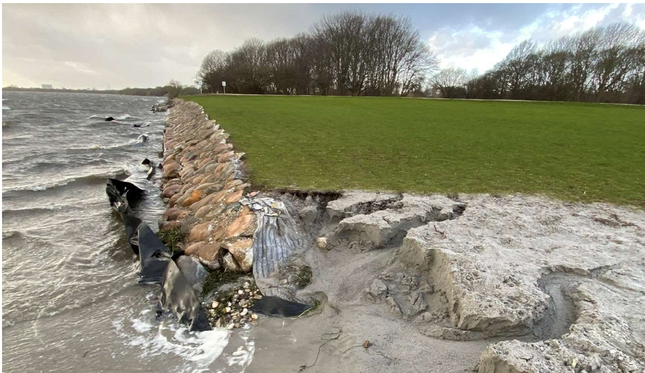
Figur 4 – Billede februar, Blotlagt membran foran stenglaci mod vest
