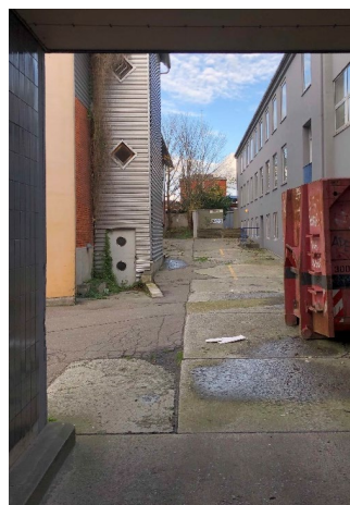
Smøge mellem Frederikssundsvej 276 og 274 set fra syd. Foto: Skovhus Arkitekter.
