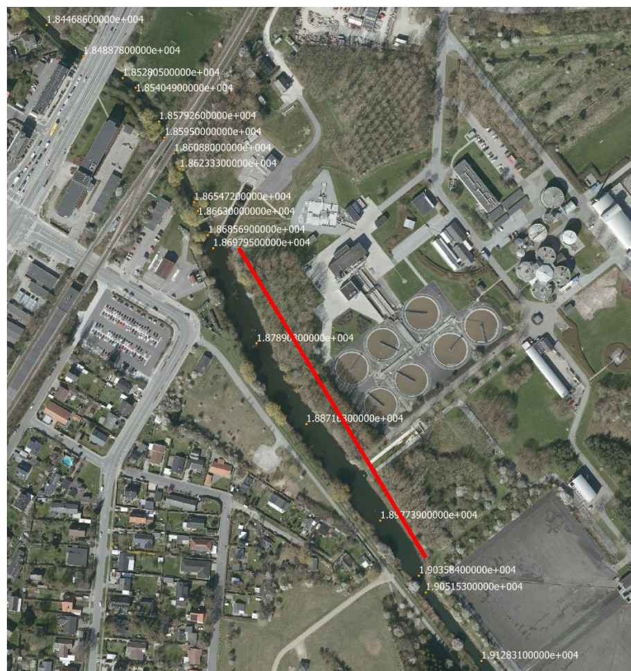
Figur 1 Luftfoto med Stationeringer i Harrestrup Å (forkert enhed) og strækning for digeforhøjelsesprojektet.
