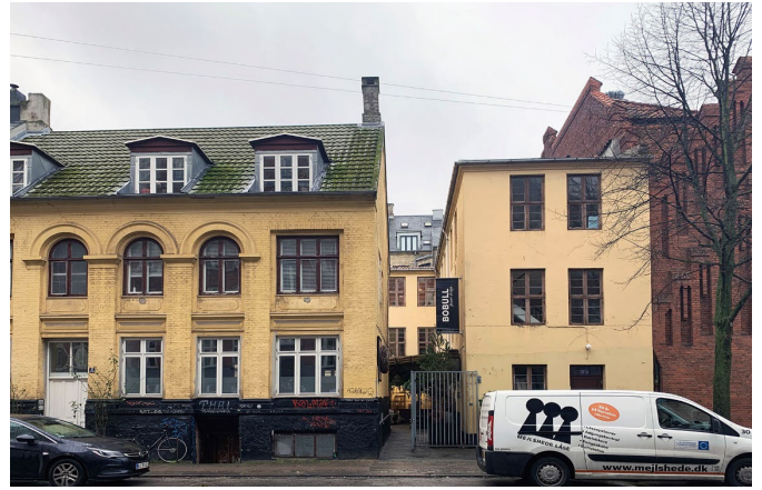
Bevaringsværdige bygninger. Beboelsesejendom på Bjelkes Allé nr. 17 (t.v.) og erhvervsbygning nr. 17A (midten), samt Anna Kirke yderst til højre.
