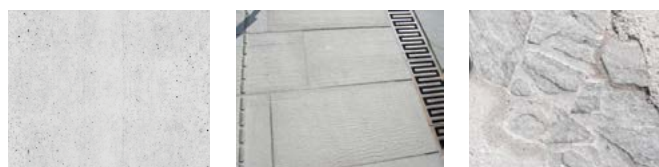
Ill. 1. Pladsens belægningsmaterialer er større betonflader som overvejende materiale, natursten til detaljering ved bla. regnvand og støbejern til linjedræn og kantning af bede. (SLA)
