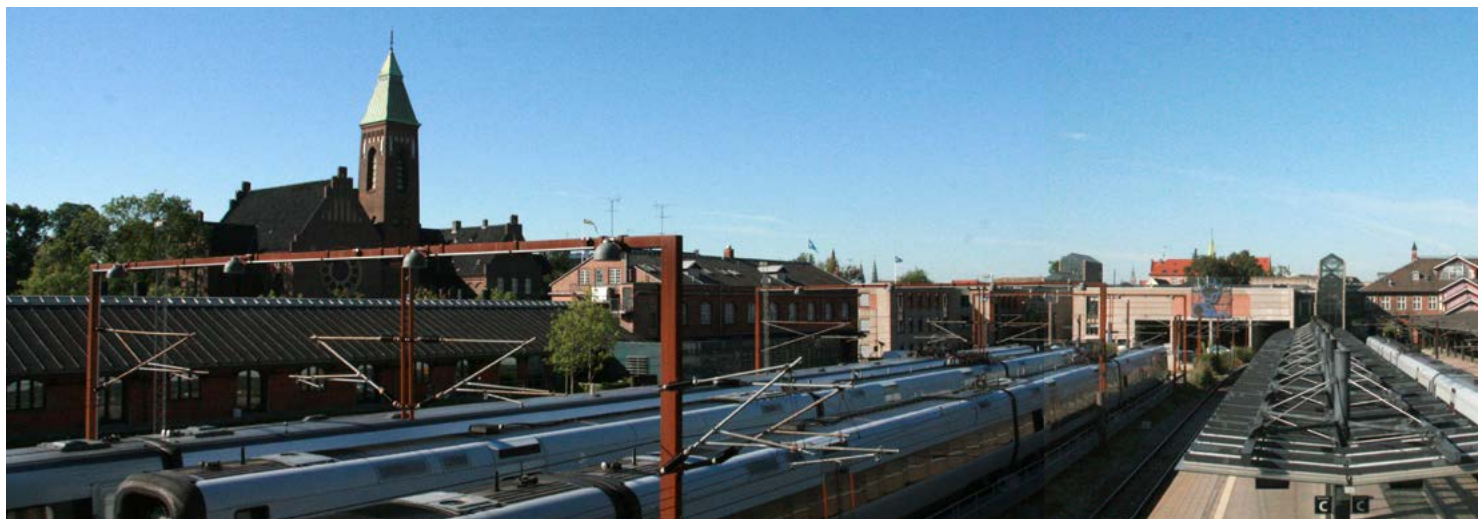
Lokalplanområdet og Østerport Station set fra bro over baneterrænet.
