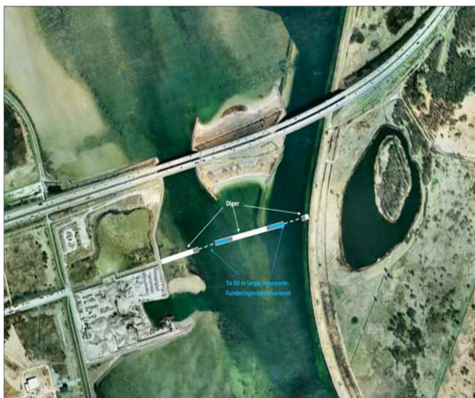
Figur 13: Dæmning og sluse ved Kalvebodløbet.
