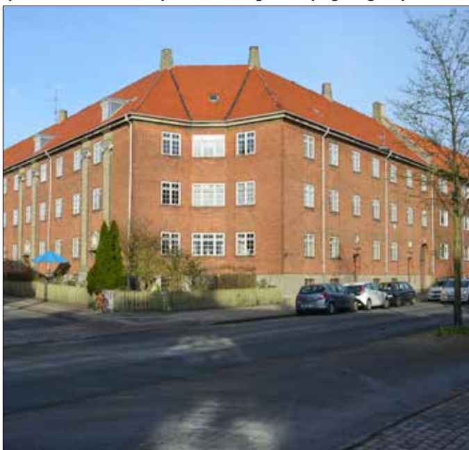
Ejendommen set fra hjørnet Vestergårdsvej og Mågevej.
