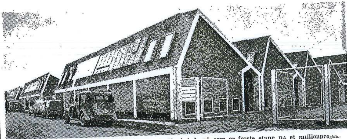
En del af den smukke nye håndværkerby på Værkstedsvej, som er første etape på et millionprojekt.
