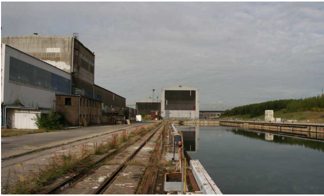
Et kig mod vest fra den østligste del af Refshalevej med tørdokken i forgrunden og den 65 m høje sektionshal i baggrunden. I hallen til venstre er der planer om at etablere en BMX-bane.
