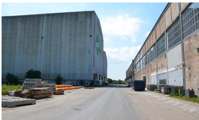
Bygningsproportionerne er store på Refshaleøen. Her mødes det gamle og det nye skibsværft med den gamle svejsehølle til højre og sektionshallerne til venstre.
