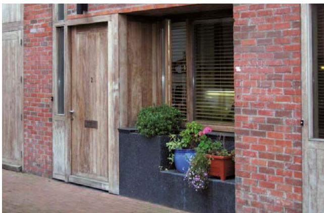
Eksempel på en indbygget kantzone der kan give variation i gadebilledet uden at tage plads foran bygningen
