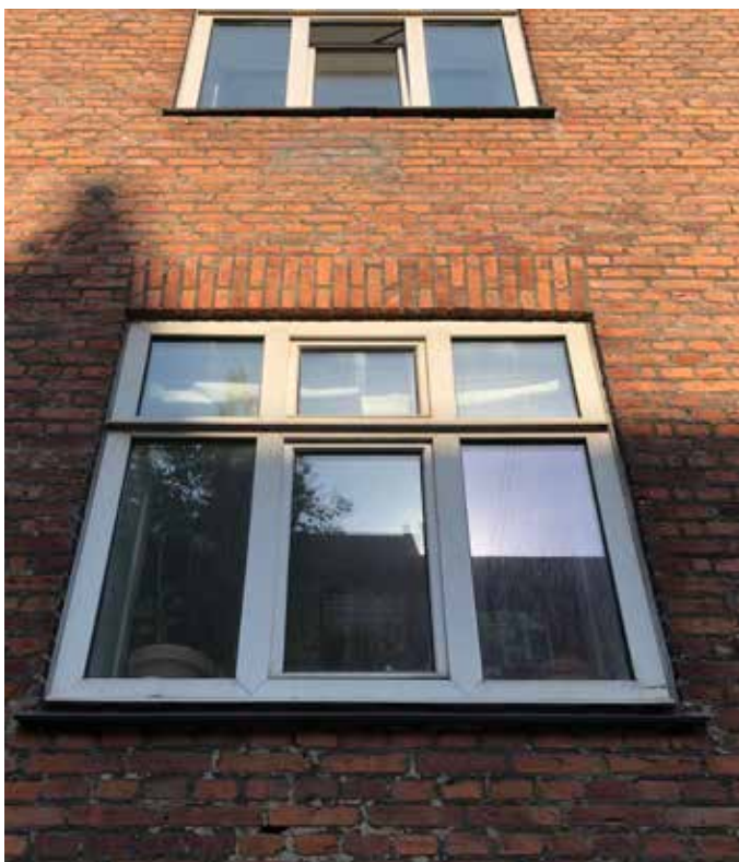
Utætte plastikvinduer udskiftes med støjrducerende træ/ træ-alu vinduer mod hhv gade/ gård. Alle sålbænke udskiftes.
