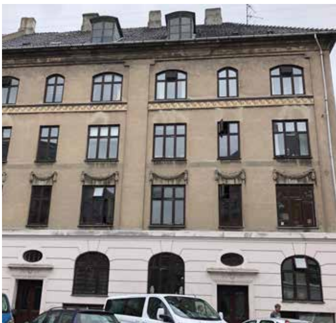
Ejendommen set fra gaden
