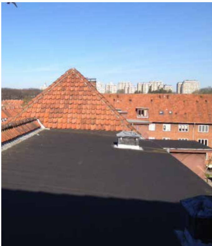
Tegltaget udskiftes, og der etableres grønne tage og solcelleanlæg.
