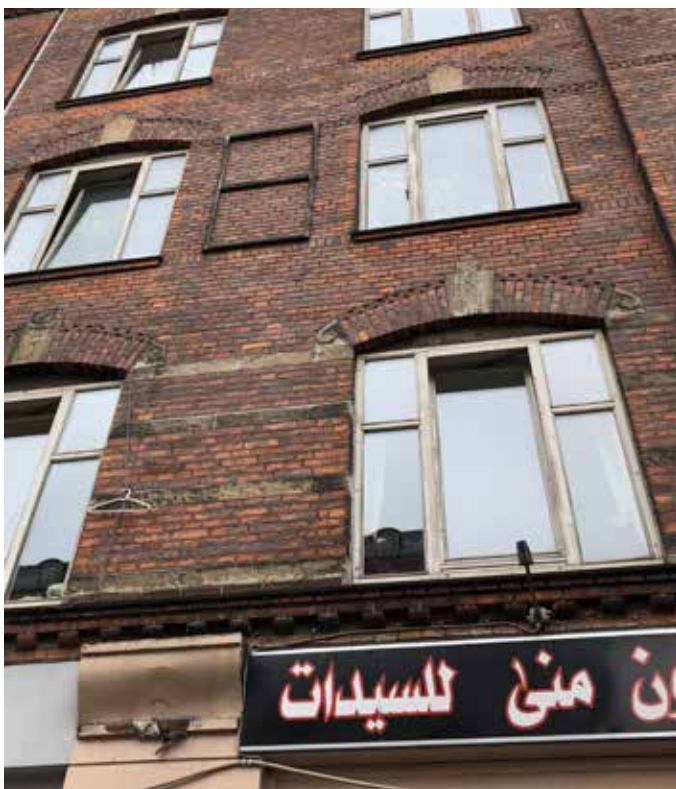
Vinduer udskiftes til koblede støjreducerende trævinduer med lavenergiglas mod gaden.
