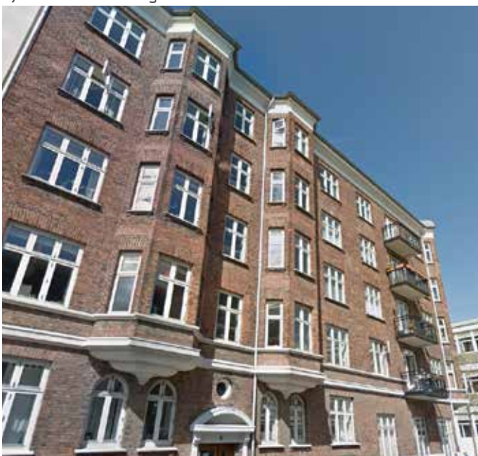
Ejendommen set fra gaden.
