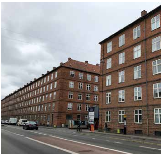
Ejendommen set fra gaden
