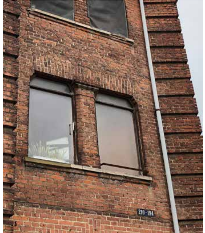
Facader omfuges og sokkel istandsættes.
