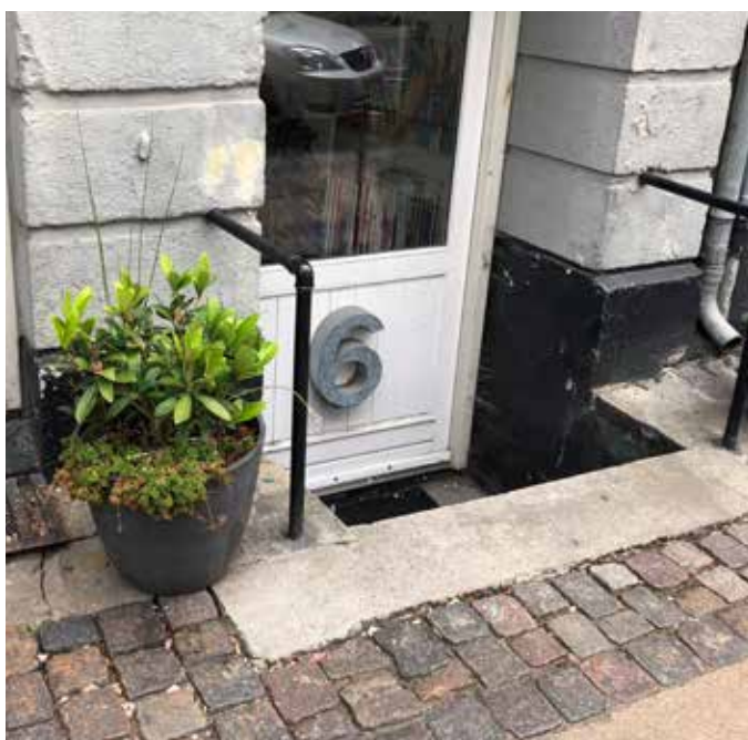
Skybrudssikring ved etablering af opkanter og omfangsdræn.
