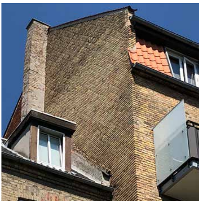
Gavl isoleres udvendigt. Vinduer mod gade/gård udskiftes.
