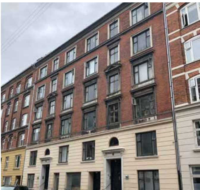
Sætningsskader og fuger reparerer. Vinduer udskiftes til trævinduer med koblet ramme mod gade og træ-alu lavenergivinduer mod gård.
