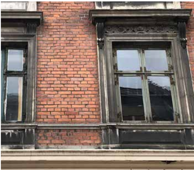
Sætningsskader og fuger reparerer. Vinduer udskiftes til trævinduer med koblet ramme mod gade og træ-alu lavenergivinduer mod gård.
