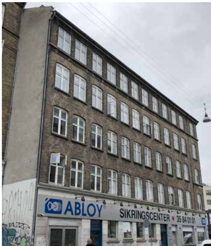
Istandsættelse facader og døre. Isolering og begrønning af gavl.
