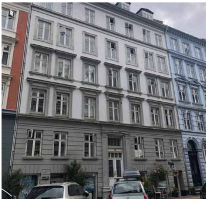
Ejendommen set fra gaden
