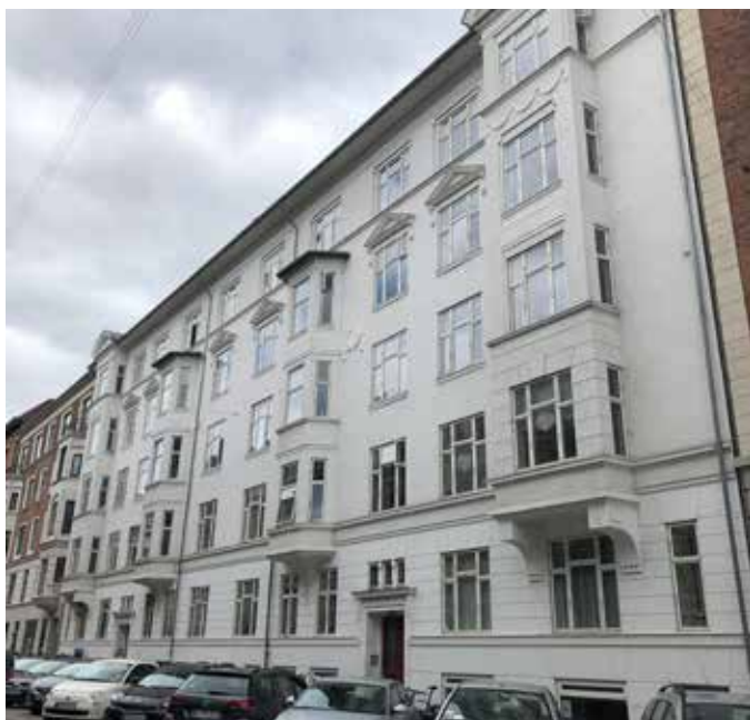
Ejendommen set fra gaden
