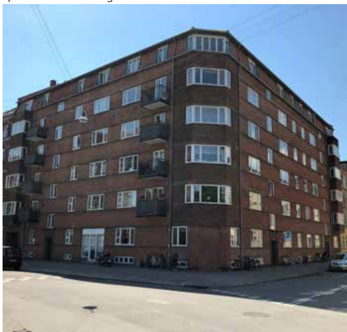
Ejendommen set fra gaden.
