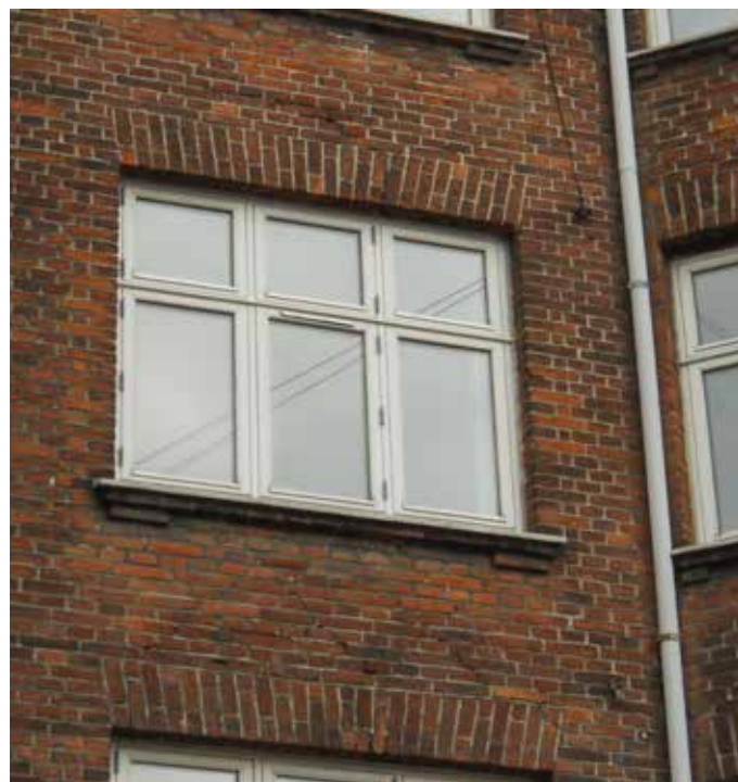
Facader renses og istandsættes/tættes ved omfugning.
