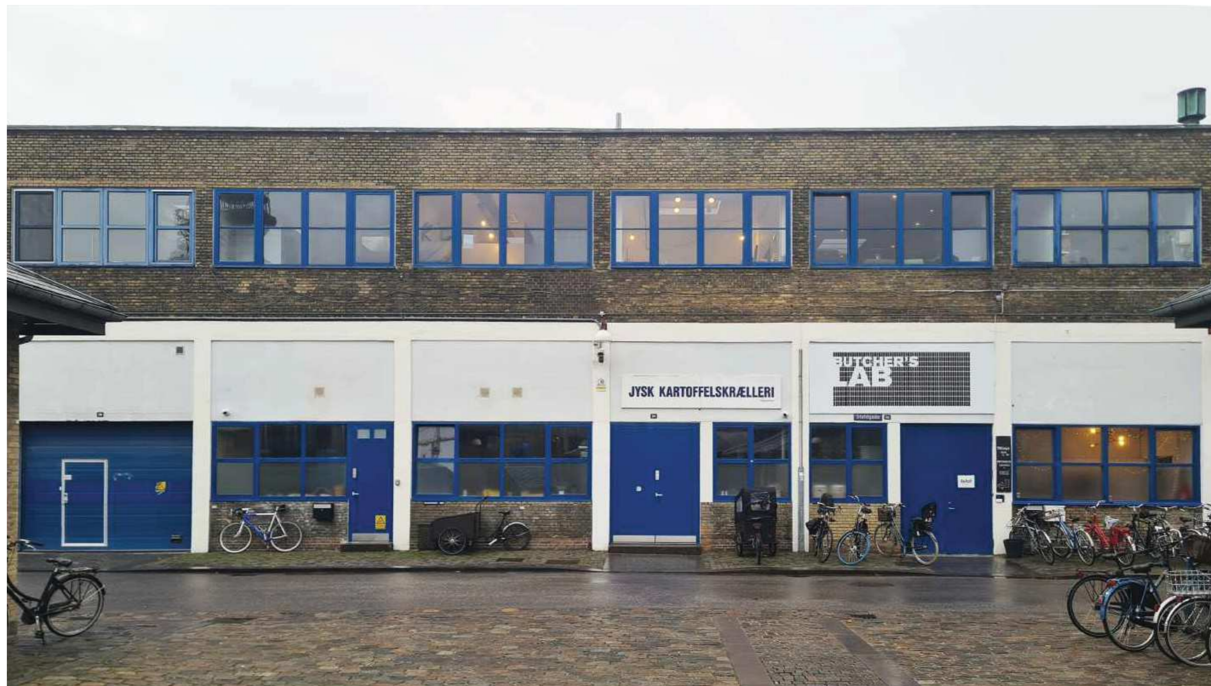
I dag ses en anonym og lukket facade i Staldgade 24-26.
