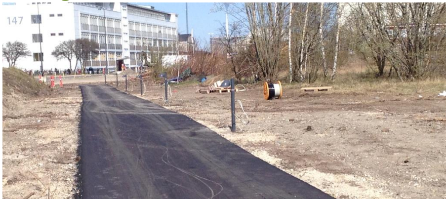
Ny cykelsti på Refshalevej
