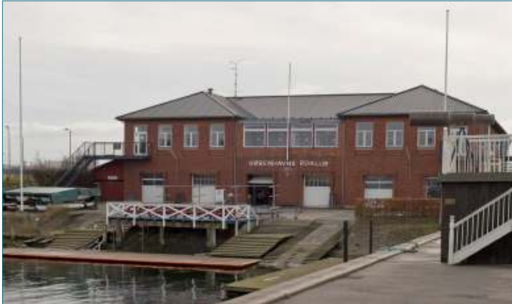
Figur 18.6 Københavns Roklub set fra hjørnet Tømmergravsgade/Skibbroen. Foran bådehuset ses roklubbens ponton i Tømmergraven. Foto: Martin Macnaughton, Orbicon.
