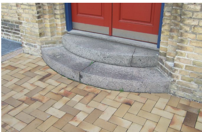
Gode materialer og fine detaljer ved indgangsdør
