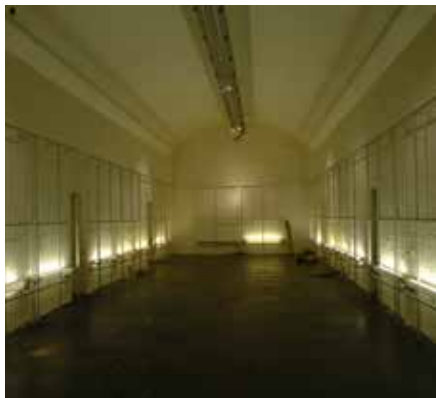
Den eksisterende kælder under pladsen.
