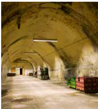
Kælderen under Rød Lagerbygning.
