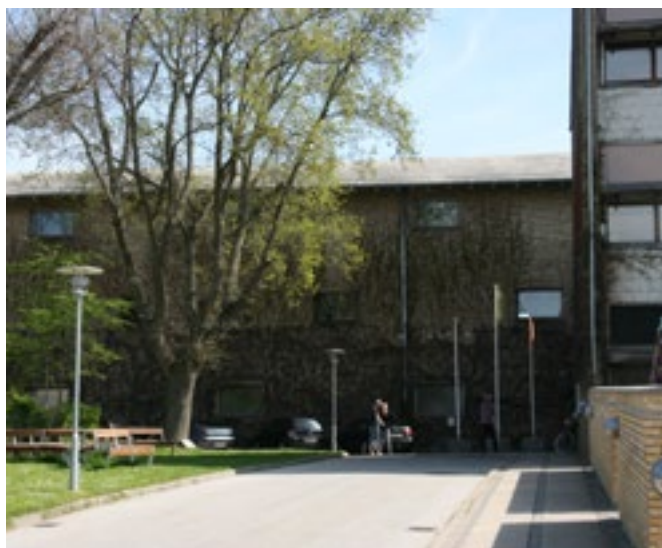
Indkørsel fra Kobbelvænget
