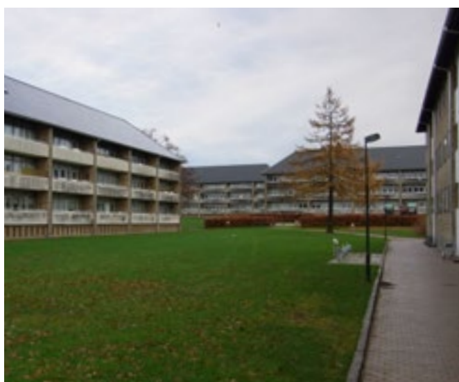
Boligkvarteret Voldparken anlagt samtidig med skolen
