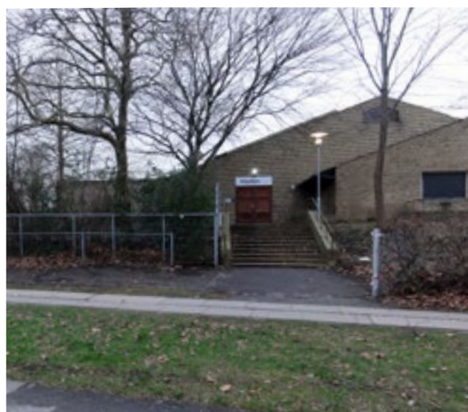
Ankomst til eksisterende hal fra Åkandevej
