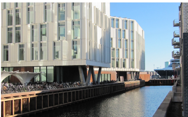
Kanalen mellem den østlige bolighalvø og FN-byen.
