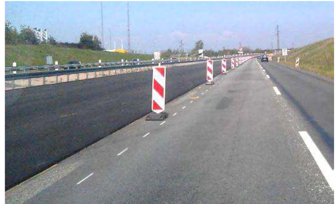
Eksempel på afspærring med N42 Kantafmærkningsplader i størrelsen 100x25 cm. Billedet er fra Vejregler, Håndbog om Afmærkning af vejarbejder, oktober 2013, figur 3.13, s. 50.
