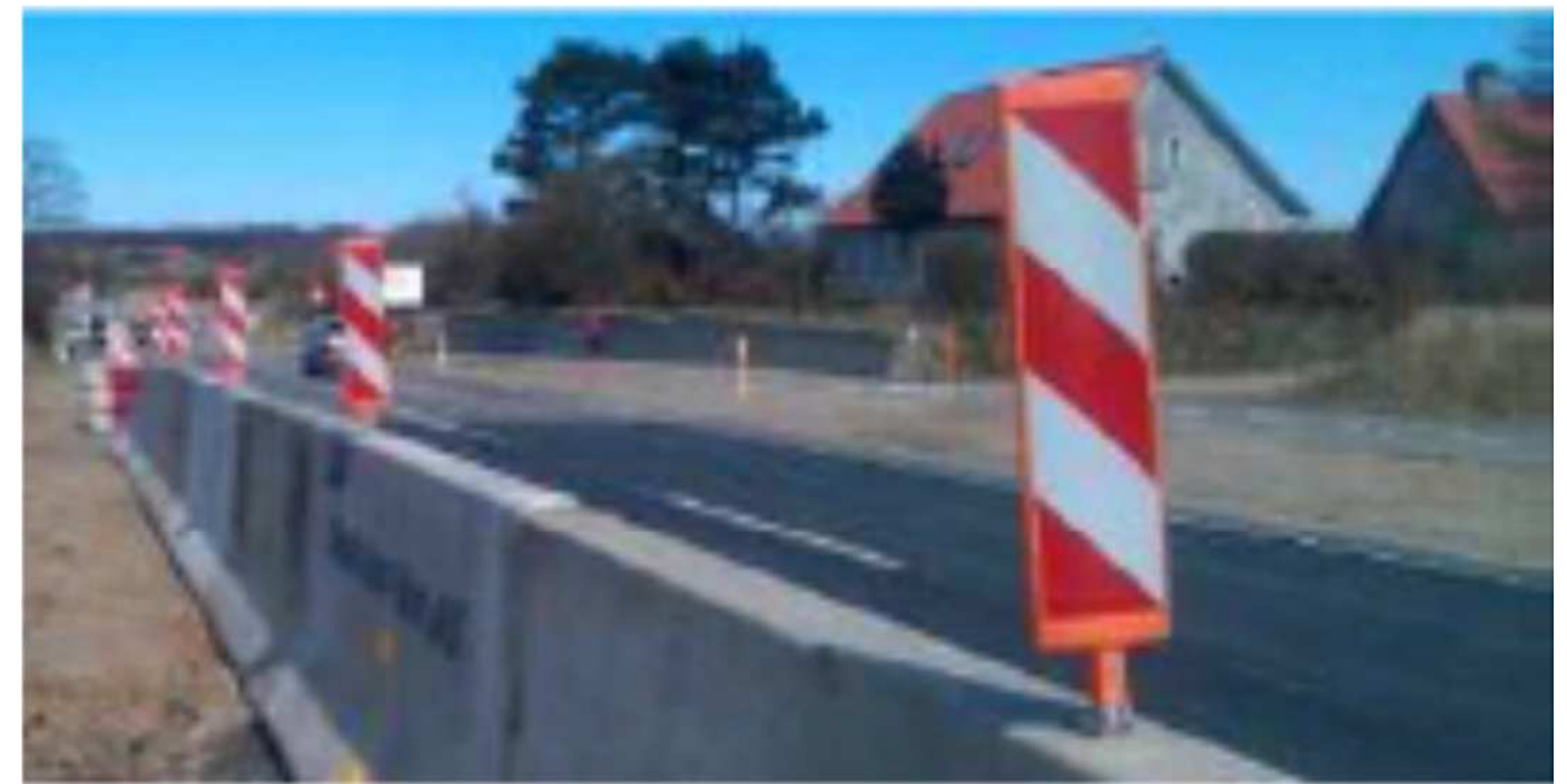
Eksempel på afspærring med trafikværn påmonteret N42 Kantafmærkningsplader i størrelsen 50x12,5 cm. Billedet er fra Vejregler, Håndbog om Afmærkning af vejarbejder, oktober 2013, figur 6.17, s. 108.
