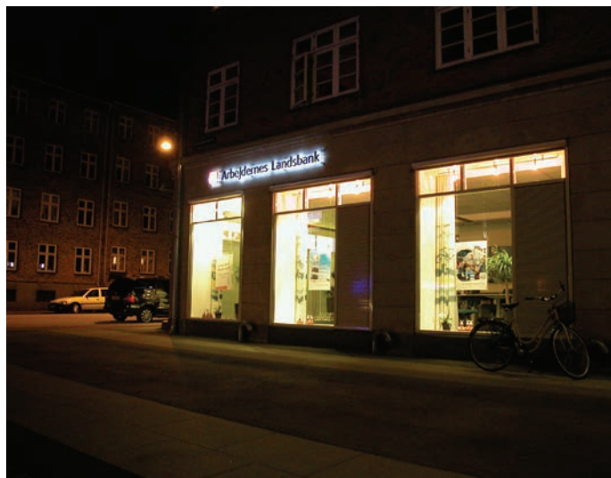
Skiltebelysning med coronaeffekt (bogstaver, der er belyst bagfra) løser på fin måde eventuelle blændingsproblemer.
