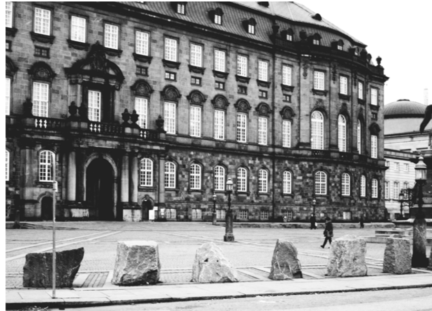
Midlertidig sikring med granitblokke
