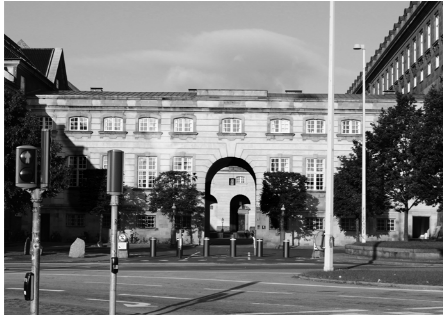
Eksisterende pullertanlæg ved indgangen til Rigsdagsgården
