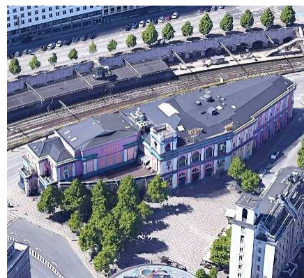
Skråfoto af eksisterende bygning set fra sydøst. Foto: Cobe.
