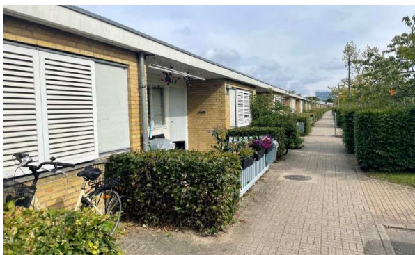
Rækkehuse på Langhusvej set fra syd. Rækkehusene muliggøres nedrevet. I stedet kan der opføres nye almene familieboliger og private rækkehuse.
