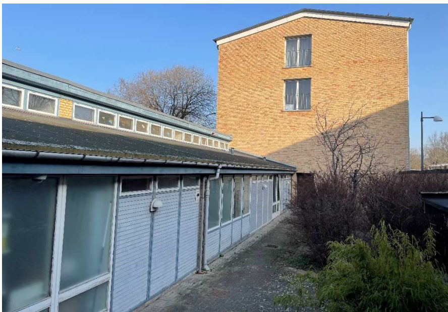
Østfacaden er ligeledes præget af elementer i højformat.
