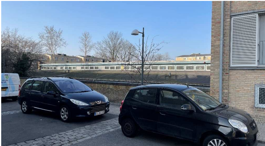
Mod øst ligger bygningen sænket og tilbagetrukket i forhold til gaden
