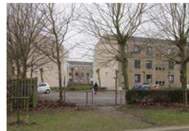
Den nordlige karré ud mod Vanløse Allé
