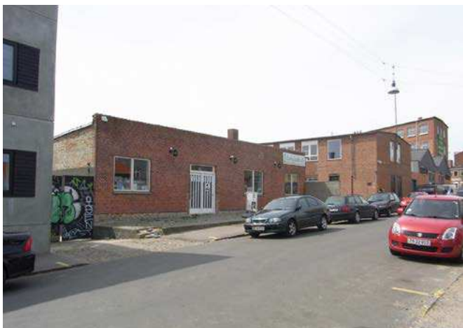
De eksisterende bygninger set fra Dortheavej
