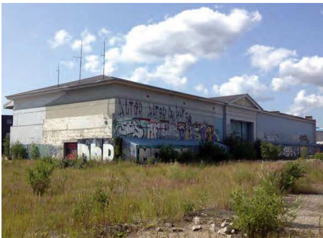
'Specialstålhallen' set fra Vasbygade. Foto: DesignGroup Architects
