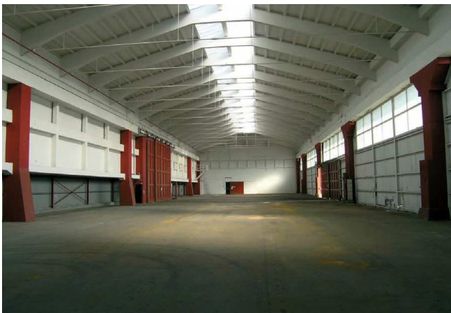
'Specialstålhallen' indvendig. Foto: DesignGroup Architects
