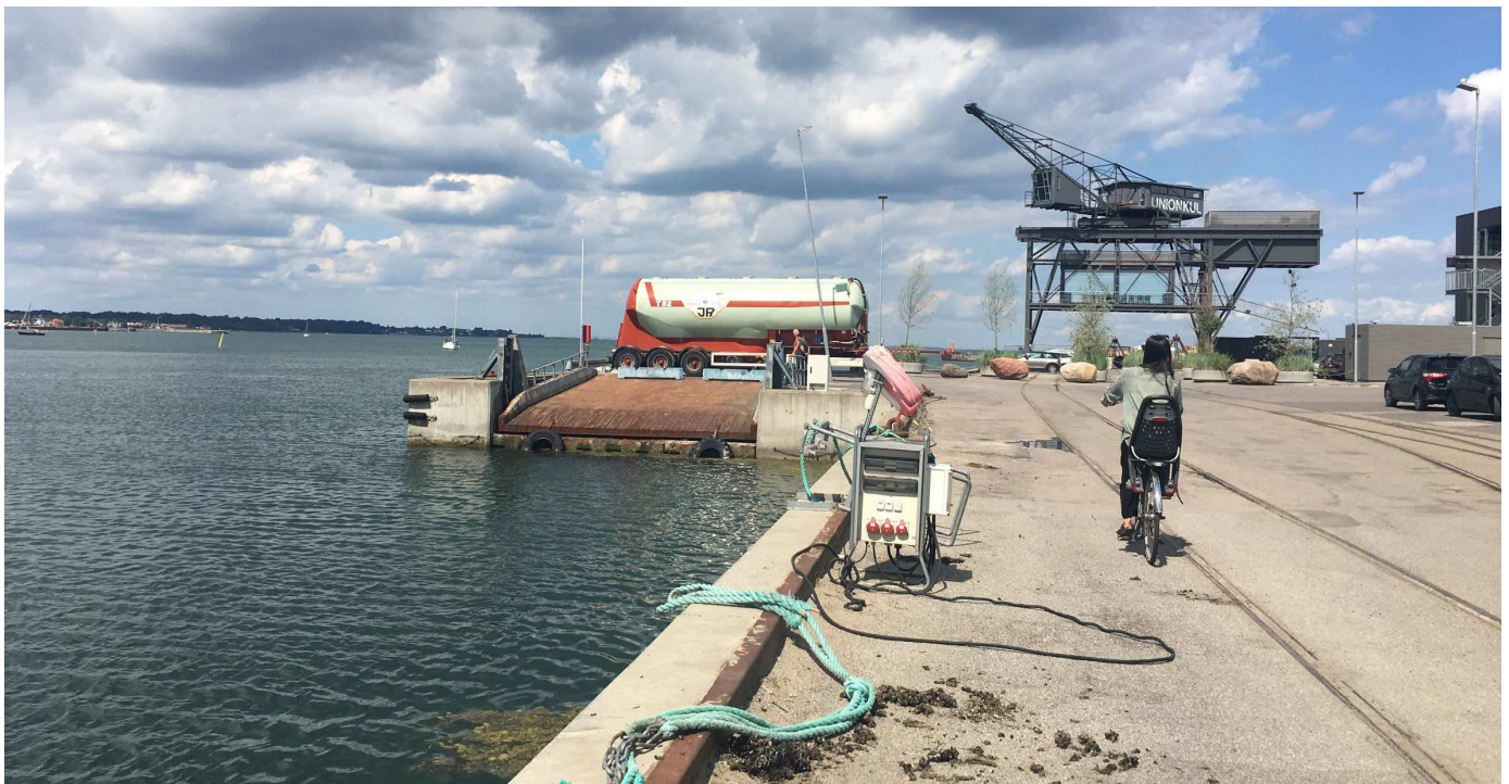
Fortøjningsringe, skinner og betonbolværker på kajen langs med Kalkbrænderiløbet. Midt i billedet ses 'færgestedet' som fremstår med en rampe af jern, og bagerst, uden for lokalplanområdet, den markante 'Unionkul Kran', der i dag bl.a. anvendes til konferencefacilliter.
