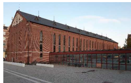
Bygning af Martin Nyrop bygget til Landsarkivet 1898. Bygningen har SAVE-værdi 2. Det foreslås, at den fastlægges som bevaringsværdig i lokalplanen.
